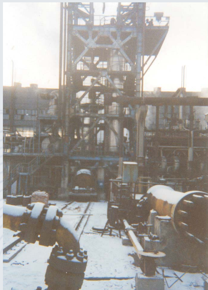
Реактор синтеза аммиака мощностью 600 т/сутки
